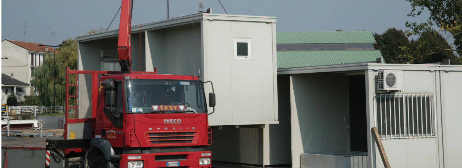
Installazione cantiere piazza Alba Iulia.
